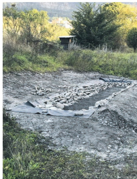
Anlage eines neuen Tümpels als Laichplatz für Gelbbauchchen (Oktober 2019; im Vordergrund), Blasenstrauch (oben rechts), Feldulme (oben links).
